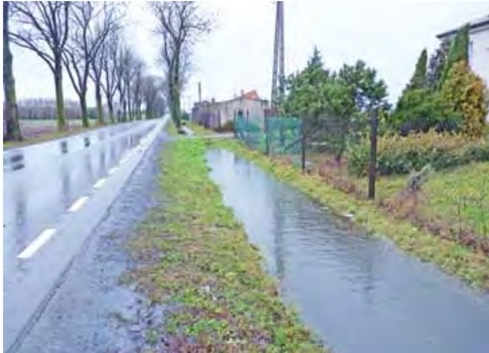
Po obfitych deszczach niektóre rowy były pełne wody. To efekt niedrożności przepustów, o które powinni zadbać właściciele posesji.
