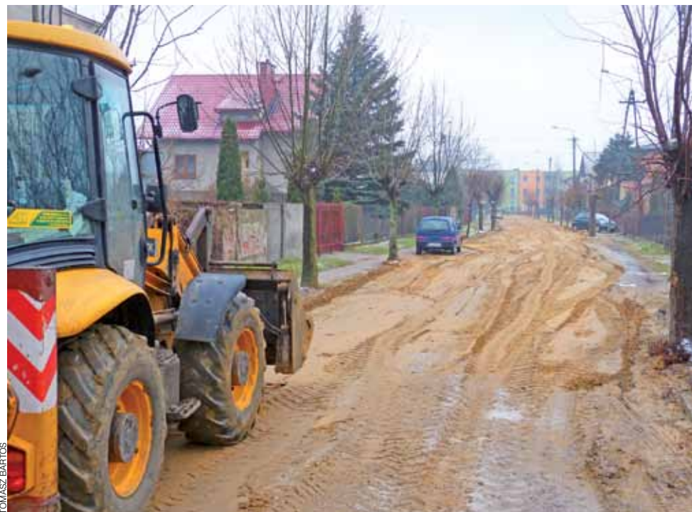
Ulica Cicha w Łowiczu po budowie kanalizacji sanitarnej i deszczowej wygląda niemal jak gruntowa.
