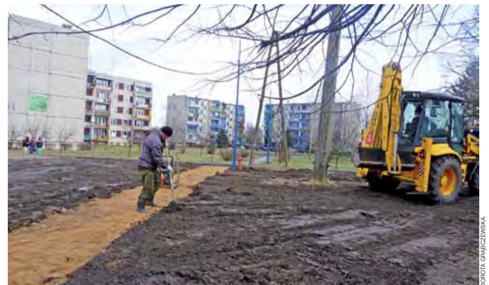
Już widać chodnik powstający od ulicy Żeromskiego do bloków spółdzielni.
