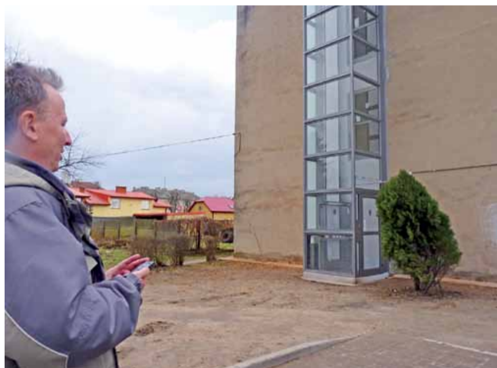
W środę, 4 marca, Wojciech Kadłubowski ze Starostwa Powiatowego w Kutnie wizytował inwestycję w Żychlinie, dzięki której od września będzie funkcjonować MOS. Krzak rosnący koło windy dla niepełnosprawnych zostanie wycięty, zrobiony zostanie także chodniczek.
