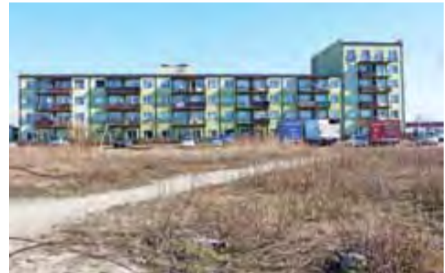
Pomiędzy blokiem a ul. Chełmońskiego miało powstać jeszcze kilka mniejszych budynków, a teren miał być zagospodarowany i ogrodzony. Żadnych z tych planów deweloper nie zrealizował.
