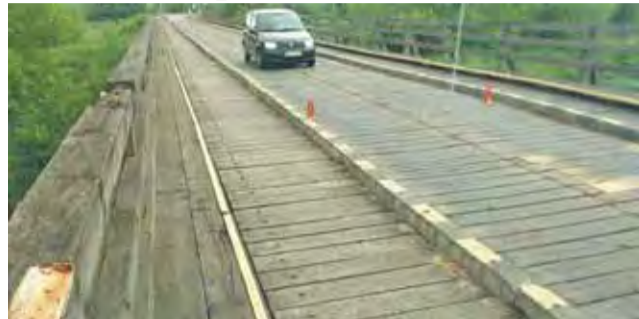
Prace remontowe mostu przeprowadzone zostaną do końca wakacji
