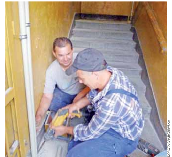
Pracownicy firmy Hydrotech z Żychlina kończą montaż pionów centralnego ogrzewania w bloku Narutowicza 85 f, który jako pierwszy ma być podłączony do instalacji.
