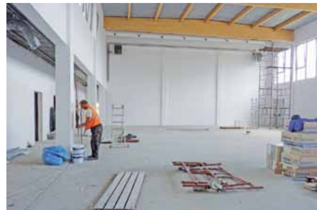
W pomieszczeniu sali zamontowano już nagrzewnice i wentylację. Trzeba jeszcze wyłożyć sufit dźwiękoszczelnym materiałem, zamontować trybuny pod filarami i ułożyć sportową nawierzchnię na boisku.
