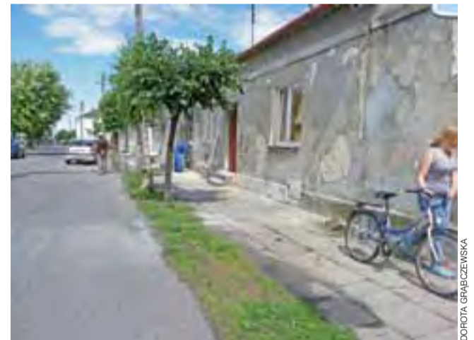
Pracownicy z Samorządowego Zakładu Budżetowego poprawiają zniszczoną elewację na budynkach komunalnych przy ulicy Ściegiennego.
