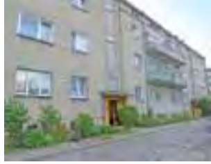
Po wielu latach mieszkańcy bloku Hanki Sawickiej 5/1 doczekają się kompleksowego remontu.
