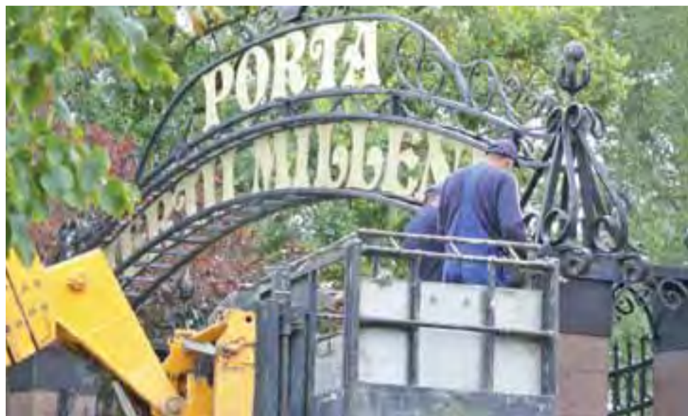
Brama Trzeciego Tysiąclecia w czasie demontażu.
