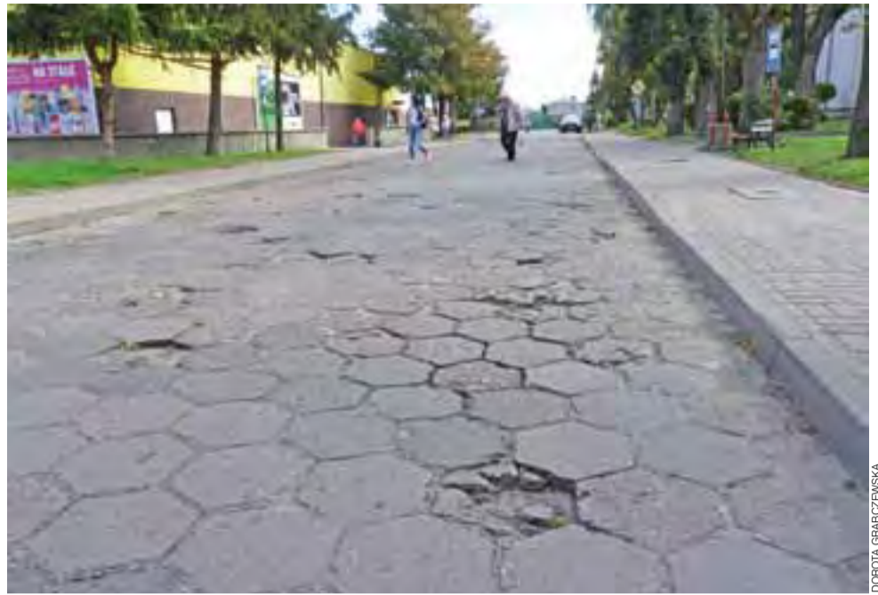
Wkrótce rozpoczną się roboty przy modernizacji ulicy Marchlewskiego. Dotychczasową dziurawą i wypaczoną trelinkę zastąpi nawierzchnia asfaltowa.
