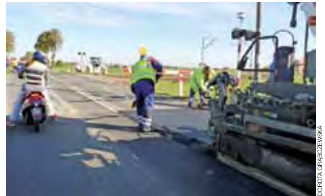
Do 15 października drogowcy mają ułożyć nową nakładkę bitumiczną od przejazdu kolejowego w Janowie do skrzyżowania z DK 92 w Bednie.
