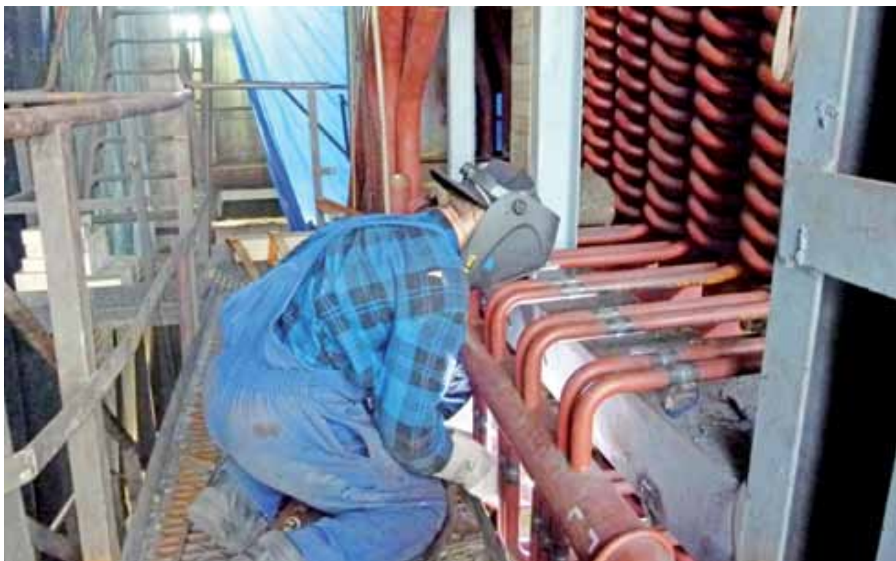
Pracownicy remontujący piec muszą wykonać setki spawów, a później każdy z nich musi zostać prześwietlony – jeszcze przed wykonaniem prób ciśnieniowych.
