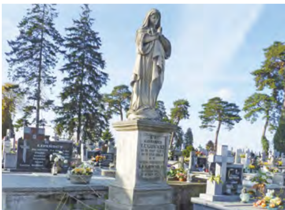
W tym roku, dzięki pieniądзом zebranych z kwesty, renowacji zostanie poddany pomnik Aleksandra Ługowskiego z 1864 roku oraz Matyldy z Dobosiewiczów Ługowskiej. Płytę już zdemontowali pracownicy administracji cmentarza, którzy włączyli się do przedsięwzięcia.
