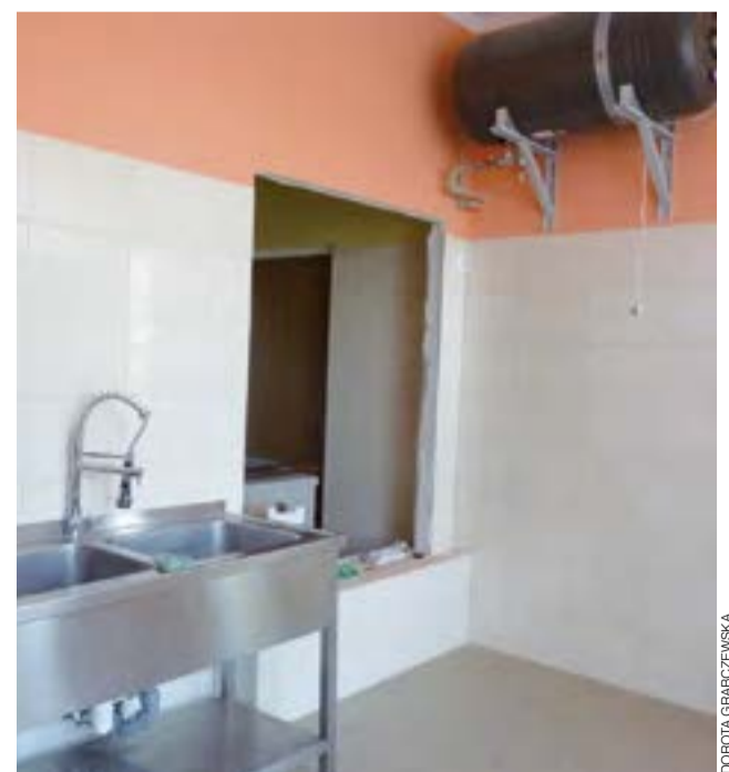
Modernizacja bloku żywieniowego w przedszkolu w Skrzyszewach zakończona. W widocznej na zdjęciu wnęce zostanie jeszcze zamontowana szafa na naczynia.
