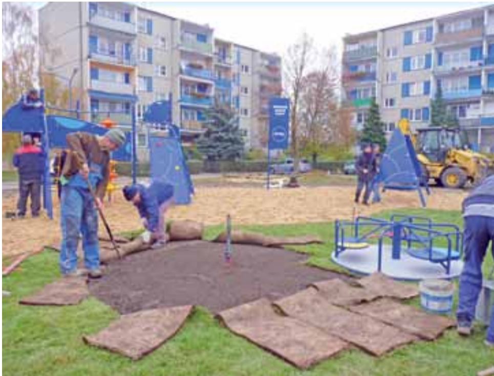
Układanie trawy z rolek pod karuzelą.
