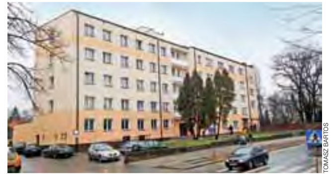
Budynek Kaliska 6 – ratusz planuje, po adaptacji pomieszczeń nieczynnej kotłowni, stworzyć w niej 4 mieszkania dla repatriantów.
