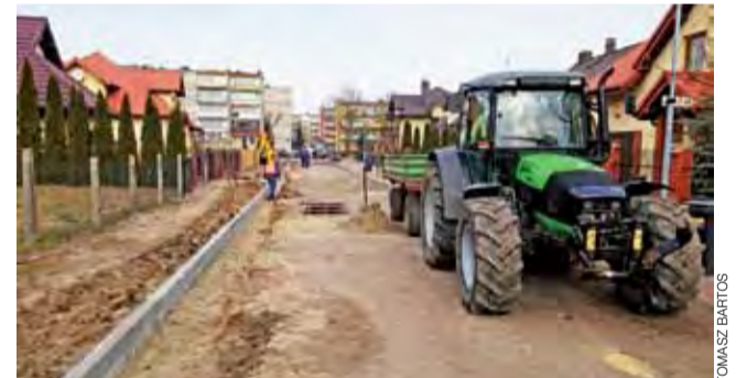
Pracownicy ZUK rozpoczęli prace na ul. Braterskiej od ułożenia krawężników i poprawek wodociągowych.
