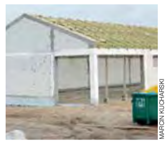
Market Dino powstaje na prywatnym gruncie.
