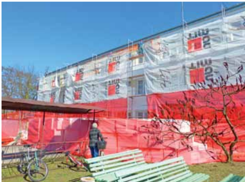
Budynek administracyjny ZOZ od strony podwórka jest zastąpiony biało-czerwoną osłoną, pod którą widać pracowników na rusztowaniach.
