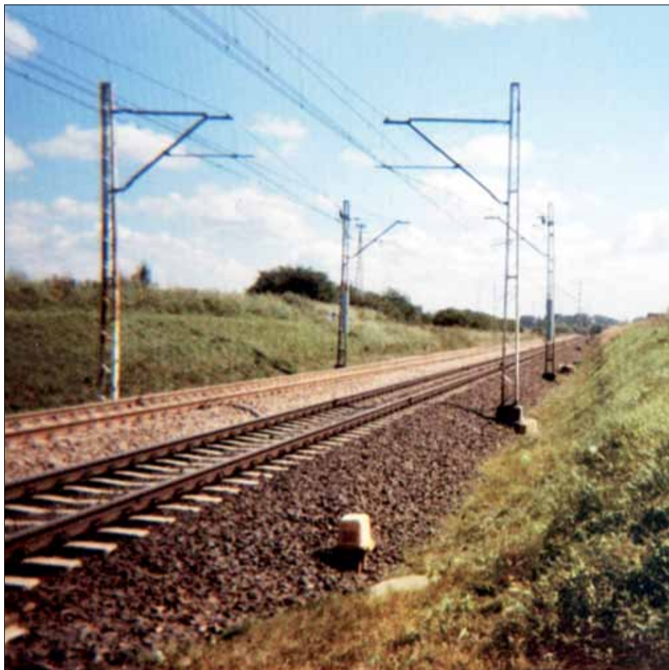
Tory kolejowe pod Szymanowicami w kierunku stacji kolejowej w Jackowicach - miejsce akcji z 2.04.1944 r., fot. współcz. D. Jędrzejczyka
