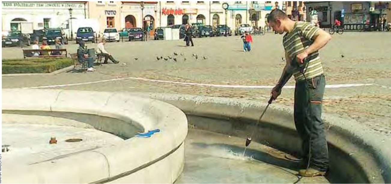
Pracownik Zakładu Projektowo-Remontowo-Budowlanego Andrzeja Malczyka oczyszcza myjką fontannę.
