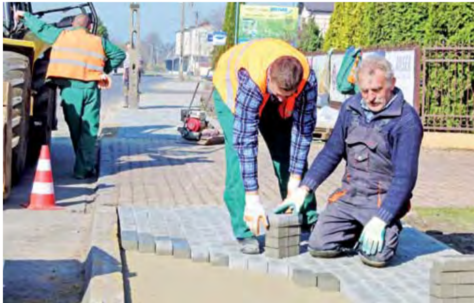
Pracownicy ZUK wykonują prace w różnych częściach miasta. Nie zawsze jest to tak blisko siedziby firmy, jak widoczna na zdjęciu budowa chodnika na ul. Nadburzarzkiej, która prowadzona była w ubiegłym roku.
