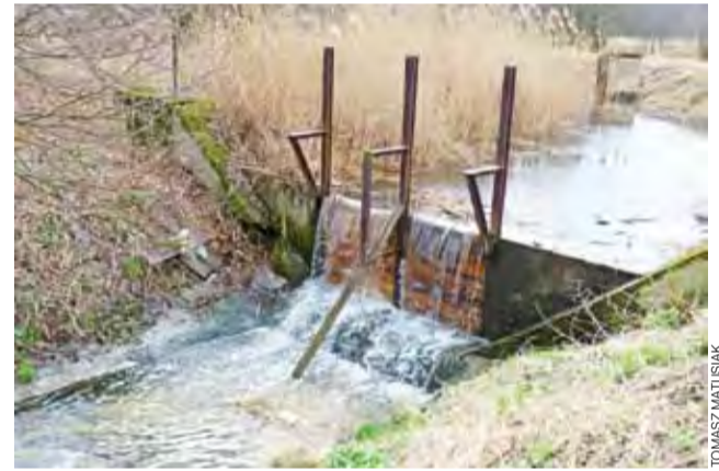
Nowy dzierżawca już zadbał o odbudowanie zniszczonej tamy.
