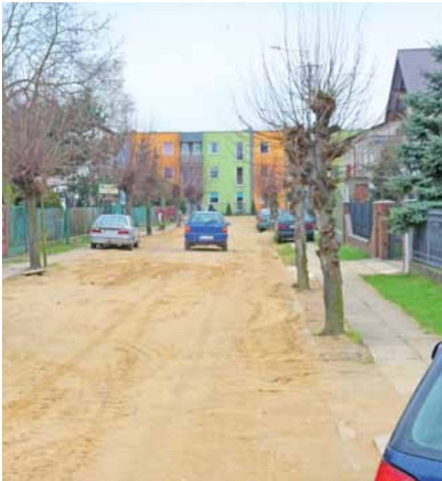
Ulica Cicha obecnie na całej długości jest wysypana żółtym piachem, pod nim znajdują się resztki asfaltu.
