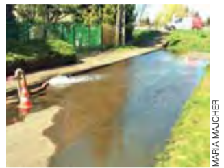
Woda lała się z hydrantu przy ul. Spokojnej.
