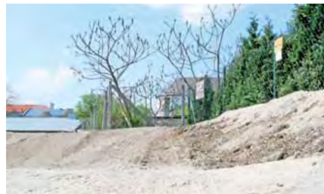
Widok z poziomu kostki – aby wjechać na ul. Rotstada, trzeba pokonać różnicę terenu wynoszącą około 30 cm.
