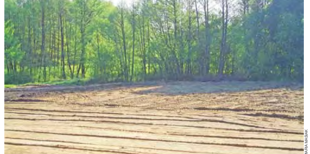
Teren, na którym powstanie boisko, został już wyrównany. Kolejnym etapem będzie utworzenie przydomowej oczyszczalni, a potem: położenie mat, siatki zabezpieczającej przed kretami, nawiezenie ziemi i posianie trawy.
