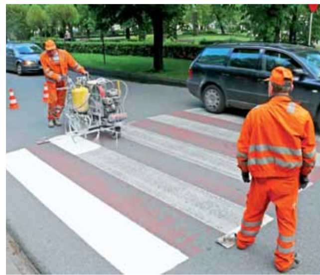
Pracownicy zgierskiej firmy Dromal malują pasy na przejściu dla pieszych przed Gimnazjum nr 1 w Łowiczu.
