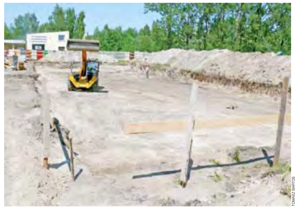
W ubiegłym tygodniu przygotowano wykop pod fundamenty bloku, który powstanie przy ul. Grunwaldzkiej.
