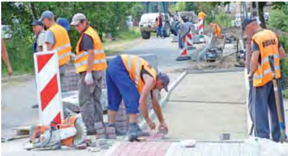
Pracownicy firmy Budmax położą już dość długi odcinek kostki przy drodze w Ostrowie.
