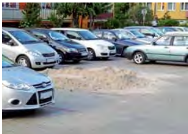
Parking jest prawie gotowy, na jego części już parkują samochody. Do wykonania są jeszcze prace wykończeniowe i porządkowe.
