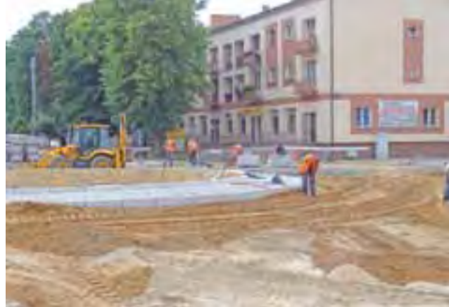
Prace przy rondzie na skrzyżowaniu ulic Stanisławskiego, Broniewskiego i Starościńskiej.
