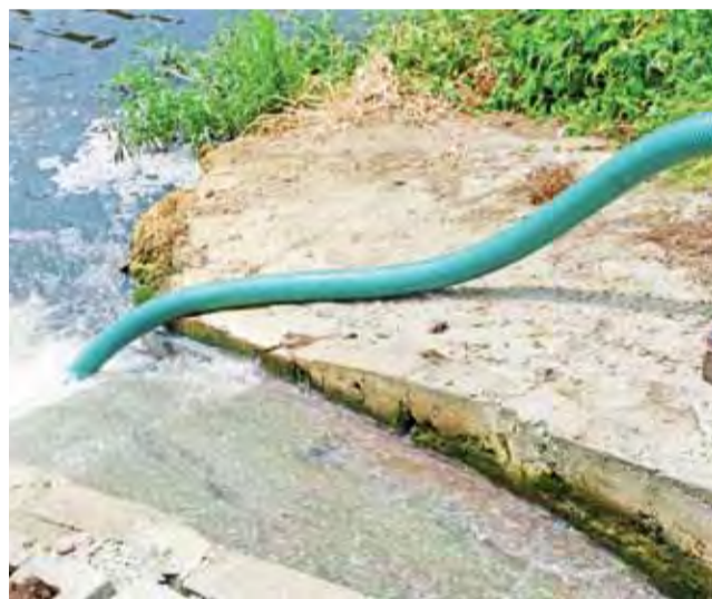
Jedno z bardzo wielu zagęszczeń nieprzyjemnie woniącego osadu w Bzurze, na terenie Łowicza.
