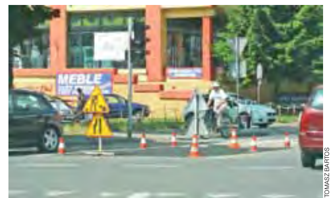
Prace na Kurkowej ZUK prowadził przy dużym natężeniu ruchu – nie mógł inaczej, był bowiem uzależniony od dostaw asfaltu.
