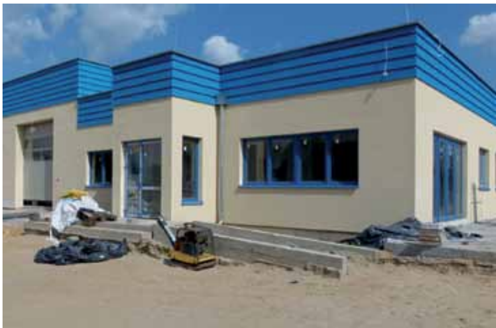
Na budowie. Powstaje Stacja Kontroli Pojazdów w Bielawach, stan na 17 lipca.
