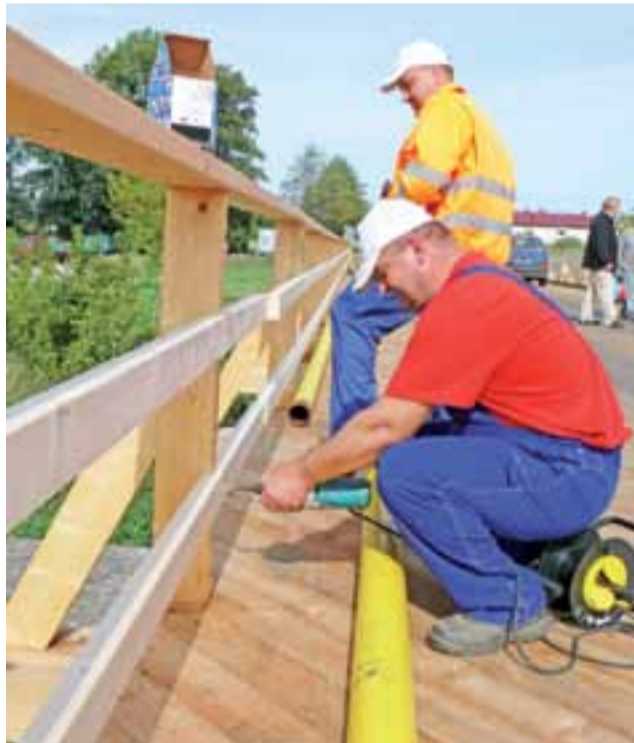
Pracownicy Powiatowego Zarządu Dróg i Transportu montują drewniane bariery na moście w Kompinie.
