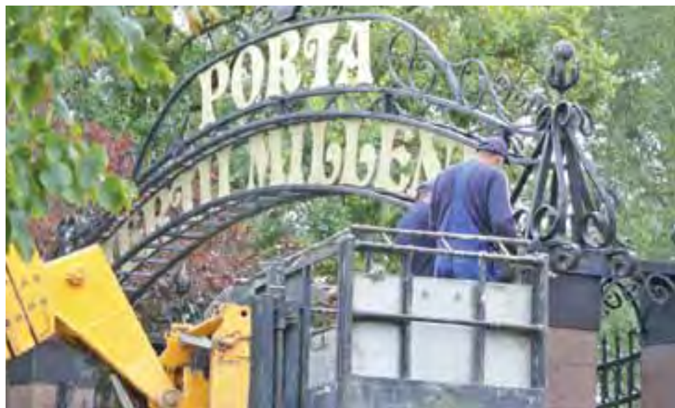
Brama Trzeciego Tysiąclecia w czasie demontażu.
