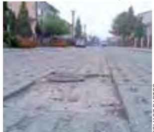
Nawierzchnia ul. Dolnej składa się w znacznej części z płyt yomba – zastąpi je kostka.
