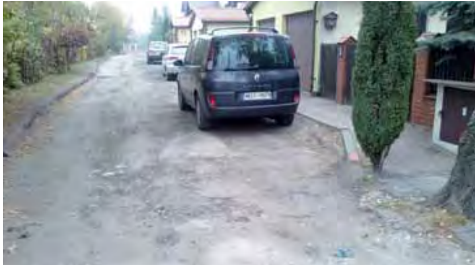
Kostka na Grabowej kończy się kilka metrów za skrzyżowaniem z Zieloną. Reszta, już wykorytkowana, czeka na asfalt.
