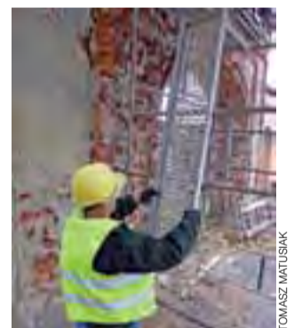
Rusztowanie przy bramie.
