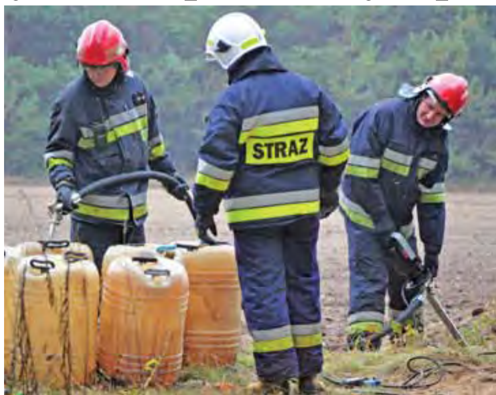
Żeby umożliwić ekipie PERN dostęp do rurociągu, strażacy musieli wypompować z wykopu łącznie ponad 1200 litrów zanieczyszczonego oleju napędowego.
