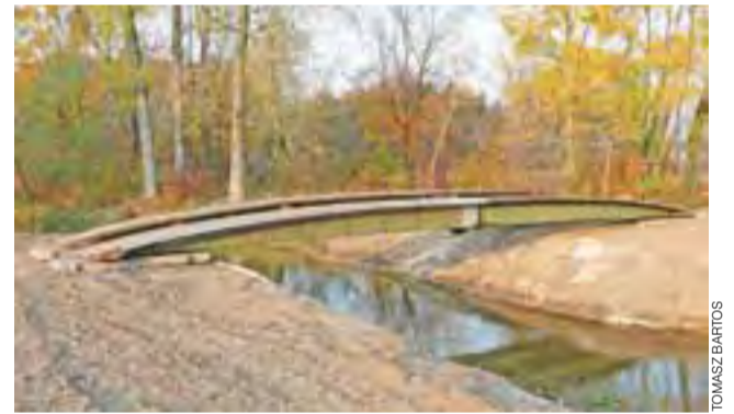
W czasie umacniania skarp Skierniewki starą kładką dla pieszych i rowerzystów zdemontowano i zastąpiono mobilnym wojskowym mostem.
