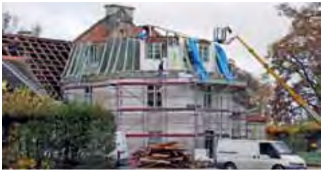
Prace obejmują wymianę poszycia i części konstrukcji dachu.
