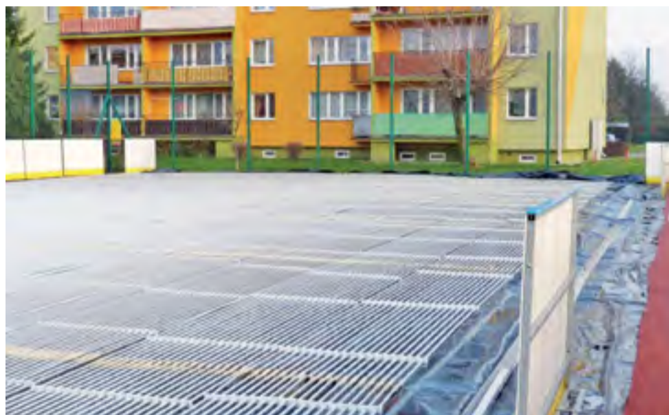
Na mniejszym boisku Orlika przy ul. Bolimowskiej ułożono już orurowanie.
