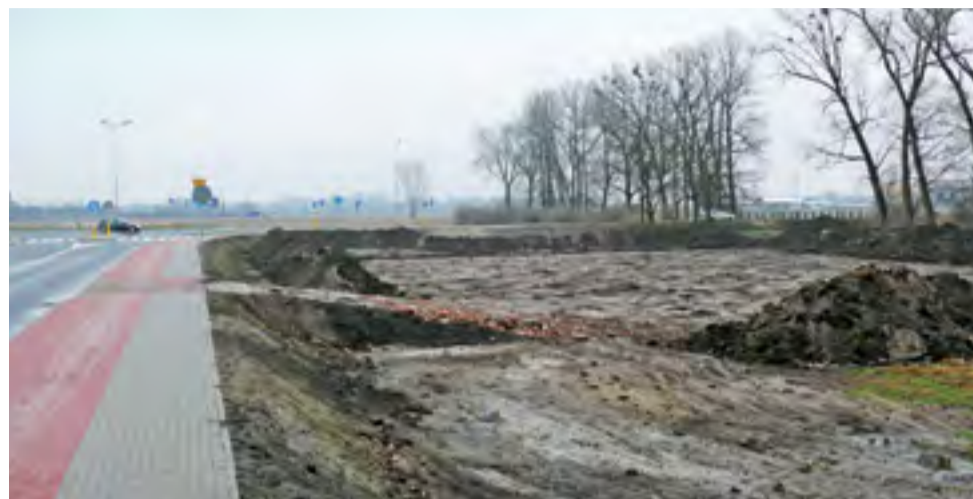
W tym miejscu nie powstanie market, a przynajmniej jeszcze nie teraz. Obecne prace związane są z podniesieniem poziomu gruntu.
