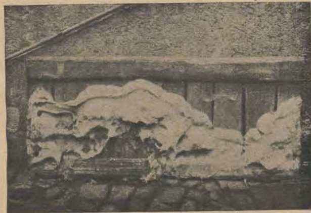
Dobrze rozwinięta grzybnia grzyba domowego „ Merulius lacrymans ”.
