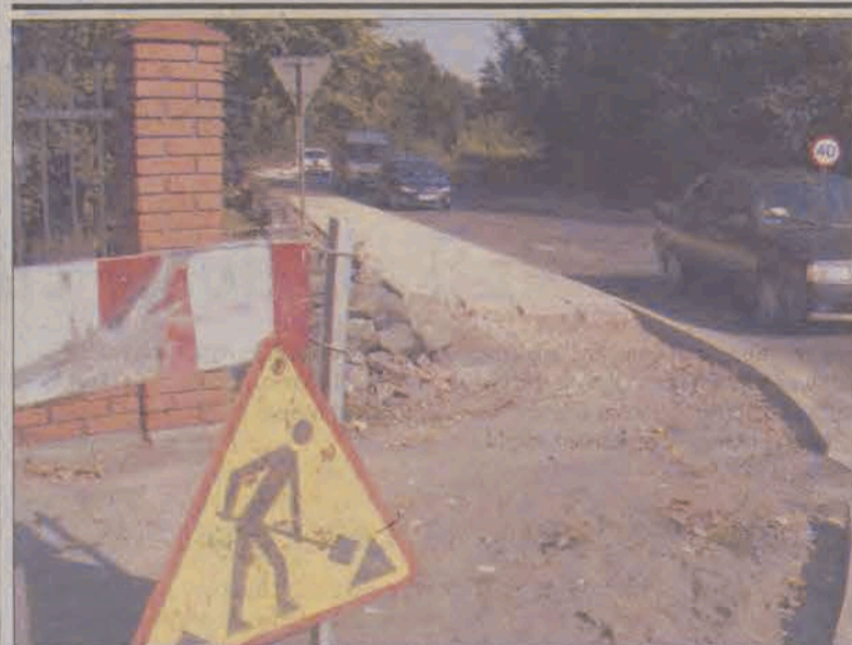
Na razie krawężnikowanie i asfalt do mostku, w przyszłym roku profilowanie zakrętu.
