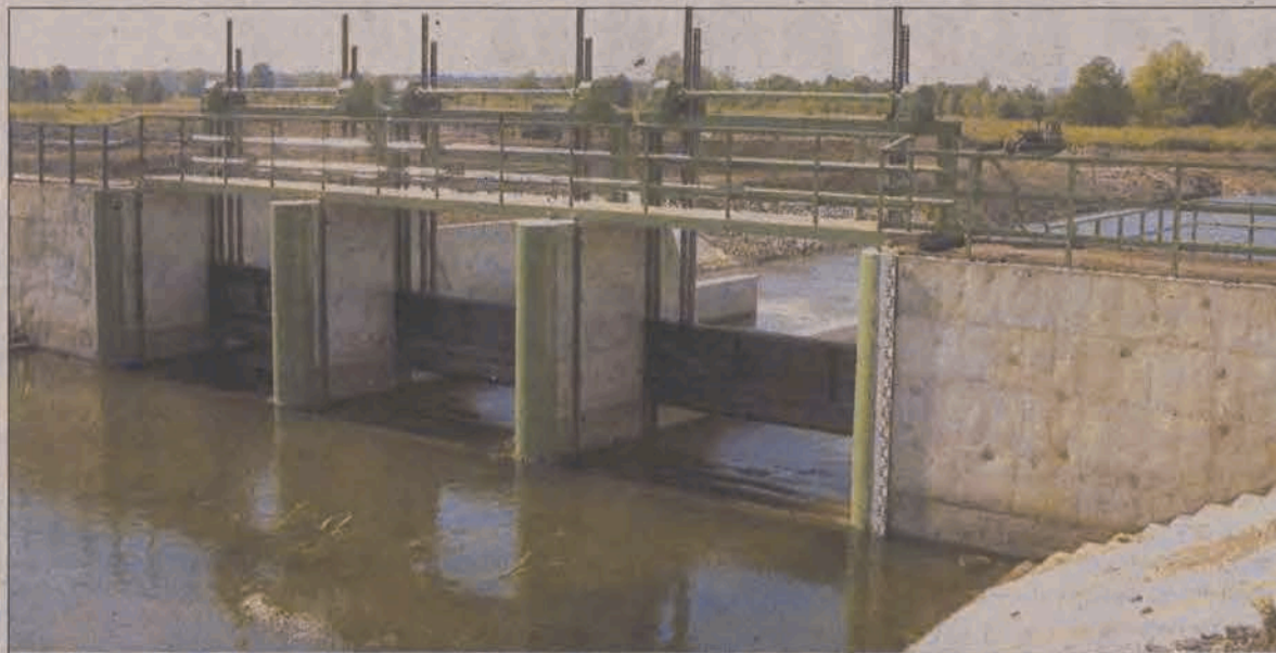
Jaz na rzece Rawce, której wody napelnia zbiornik Joachimów - Ziemiary.
