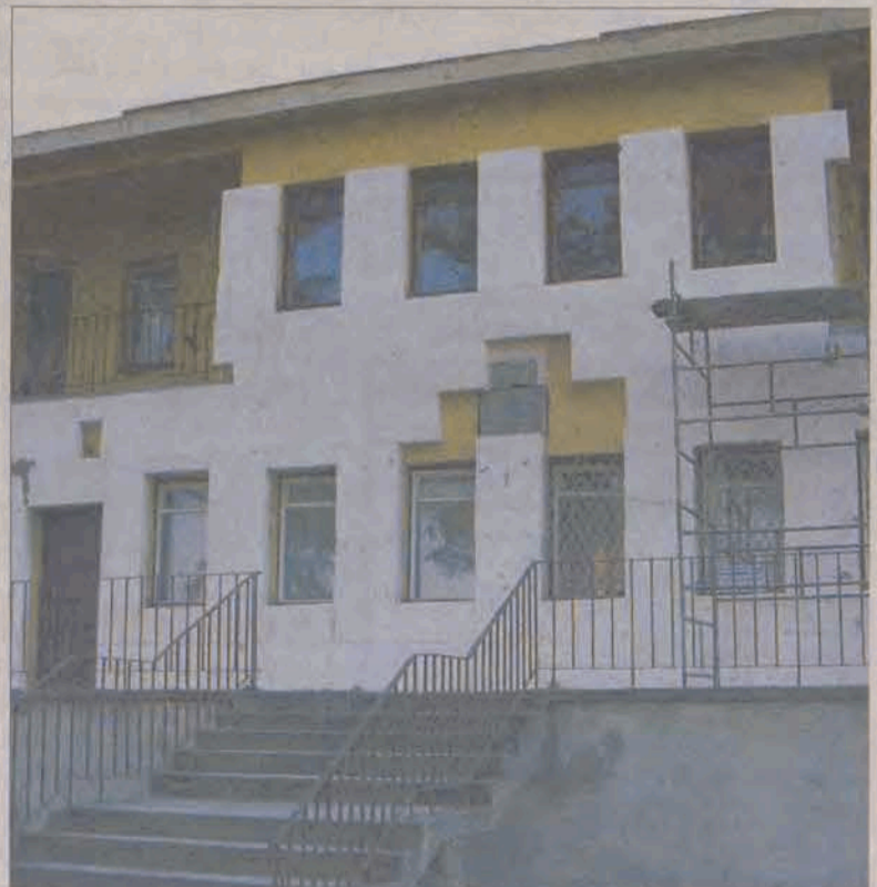
W minionym tygodniu elewacja budynku okładana była płytami styropianu.
