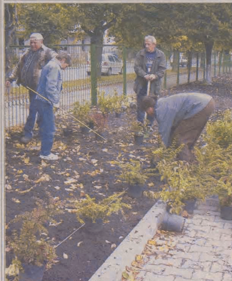
Przy nowym parkingu na ul. Swoboda prace upiększające trwają już od ubiegłego tygodnia. W ostatni wtorek, 7 października, pracownicy robót publicznych po uprzednim nawiezieniu ziemi wysadzali tu ozdobne krzewy zakupione w podstrykowskiej firmie „Tracz”.
