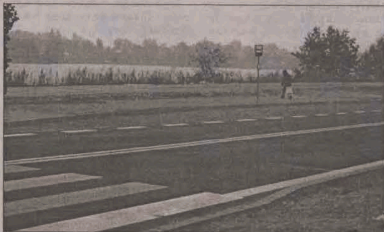
Na asfalcie widocznym w tle urządzony zostanie parking.
