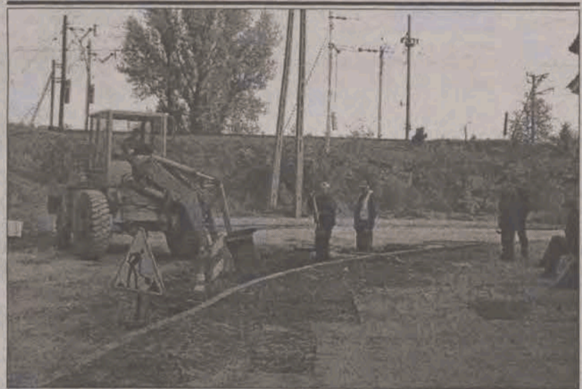
Prace przy odtwarzaniu, po położeniu kanalizacji, nawierzchni północnego odcinka ul. Tkaczew zblizają się do końca. Jak się uda, to w tym tygodniu będzie asfalt - stwierdza Tadeusz Mostowski, pracownik ZUK w Łowiczu.
