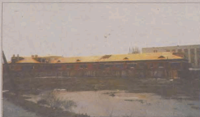
... a tak plac budowy.
