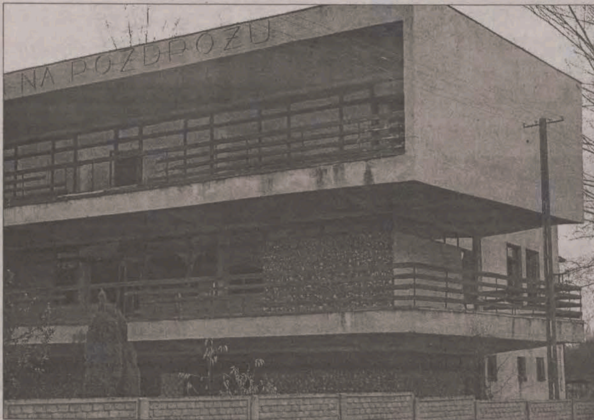
Budynek dawnej restauracji nadal straszy swym katastrofalnym stanem.
