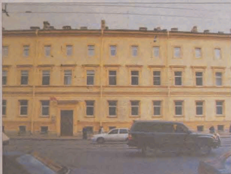
Odzyskany przez Kościół Katolicki budynek seminarium w Petersburgu.
