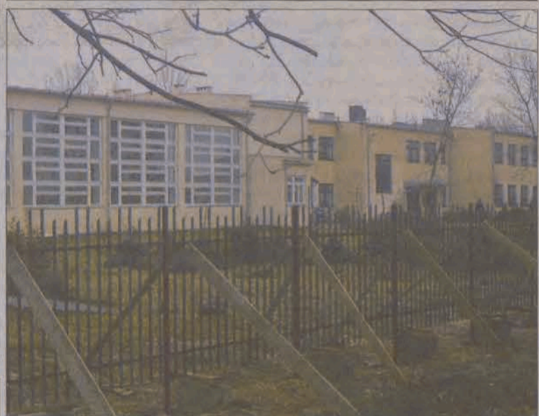
Lewa strona ogrodzenia jest już gotowa i prace przeniosą się na stronę prawą szkoły.
