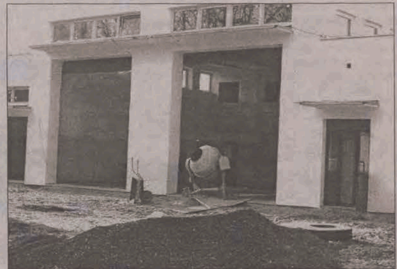
Budowa tego obiektu trwa od roku 1997.
