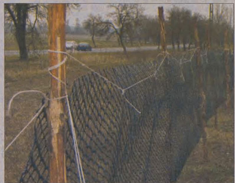
Oslony przeciwnieźne są ustawione między kilkudziesięciometrowymi odcinkami wzdłuż drogi z Łowicza do Łodzi.
