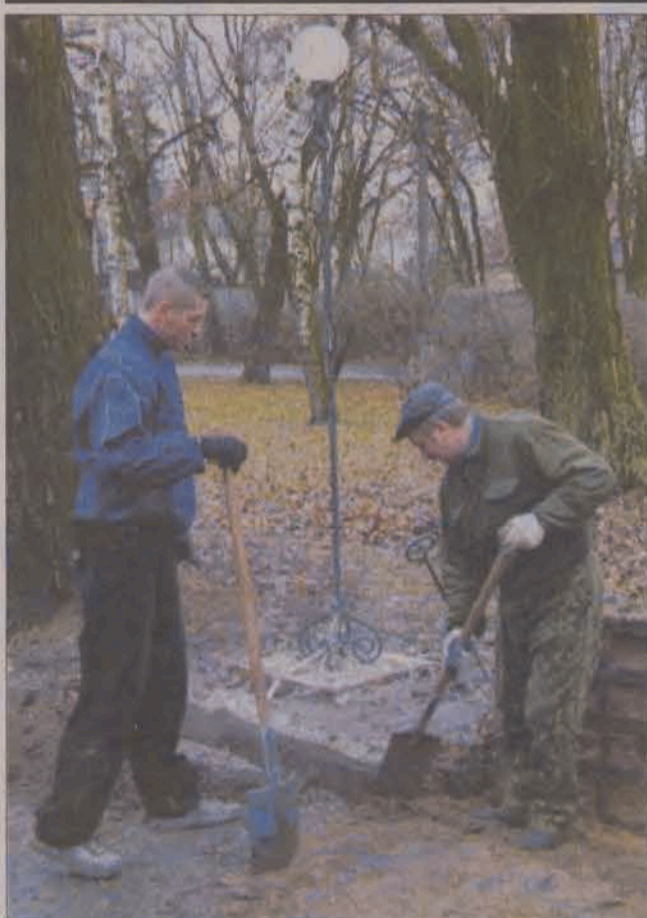
Jaśniej w parku. Cztery lampy zamontowano w ubiegłą środę w parku, który dzieli ze sobą Zespół Szkół Ponadgimnazjalnych w Zduńskiej Dąbrowie i Zespół Szkół Licealnych w Nowych Zdunach. Koszt ich zamontowania w wysokości, około tysiąca złotych pokrył zaprzyjaźniony z pierwszą z wymienionych placówek sponsor, ta też zatrudniła do ich wykonania swoich konserwatorów. Lampy oświetlą alejkę stanowiącą drogę od wejścia do budynku, w którym mieści się placówka, do terenu bloków mieszkalnych. (tb)
