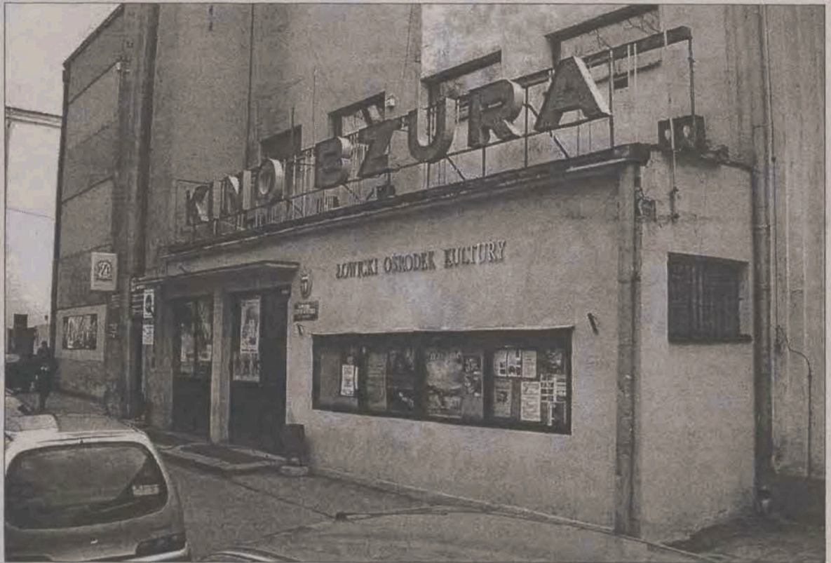
Budynek kina „Bzura” wymaga wielkich nakładów tak z zewnątrz...
