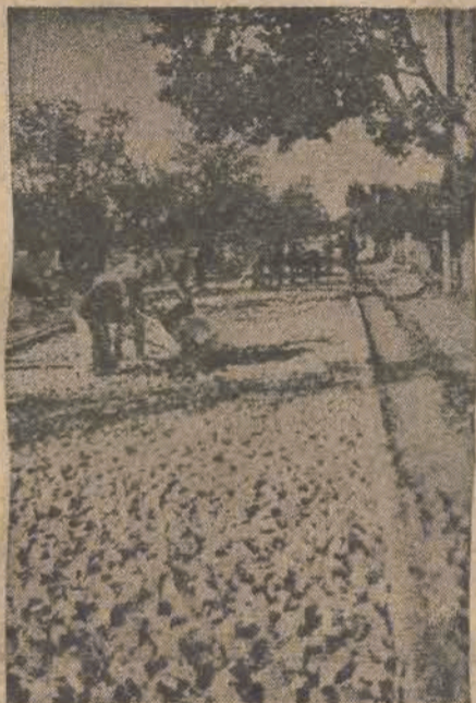
Budowa szosy, łączącej Jasieniec ze Skarżyskiem i Iłżą.
