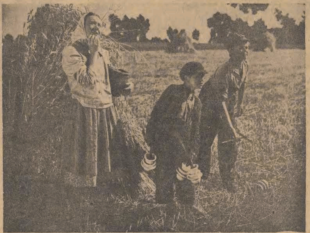
Dzieci i kobieta przyglądają się pracy elektryka-w na słupach
