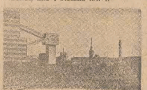
Kopalnia „Zabrze — Wschód“ Widok ogólny
