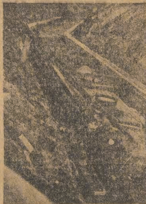
Nowe koryto Łódki w budowie
