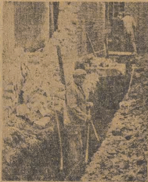
Pospiesznie przeprowadza się kanalizację na terenie PZPB Nr 3
