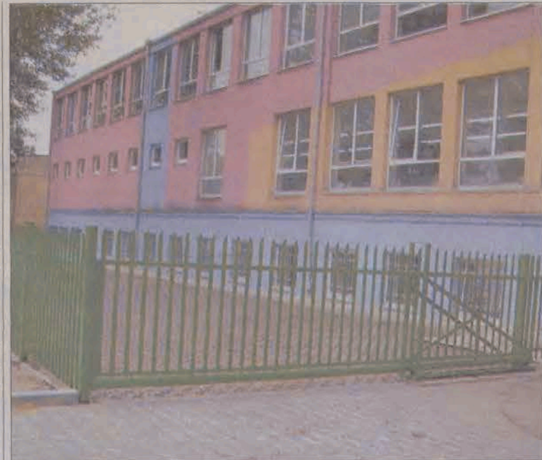
PARKING TYLKO DLA PRACOWNIKÓW. Dobięły końca prace przy budowie parkingu przy Gorseciarskiej Spółdzielni Pracy w Głownie przy ul. Swoboda 4. Niebawem zapelni się on pojazdami, ale korzystając z niego będą mogli jedynie pracownicy spółdzielni gorseciarskiej. Nowy parking, powstały w sąsiedztwie ośrodka wypoczynkowego nad Mroźyczką i miejscowego placu zabaw, ma rozładować tłok na wewnętrznym parkingu spółdzielni od strony podwórza. Zmotoryzowanym pracownikom trudno było się na nim pomieścić. By na nowy parking nie dostawały się osoby niepożądane, został on ogrodzony stalowym płotem z bramą przesuwaną. (rpm)
