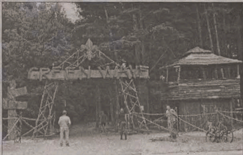
Prace przy budowie pionierki w Darłowie zaprojektowanej przez Alberta Waśkiewicza. (eb)
