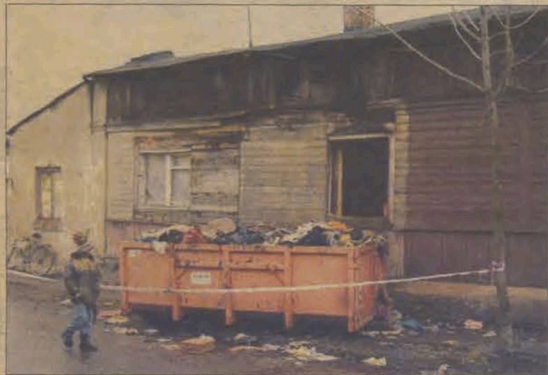
Cztery takie kontenery wypełnione śmieciami usunęli strażacy podczas akcji gaszenia pożaru w drewnianym budynku przy ul. Wolskiej 1.
