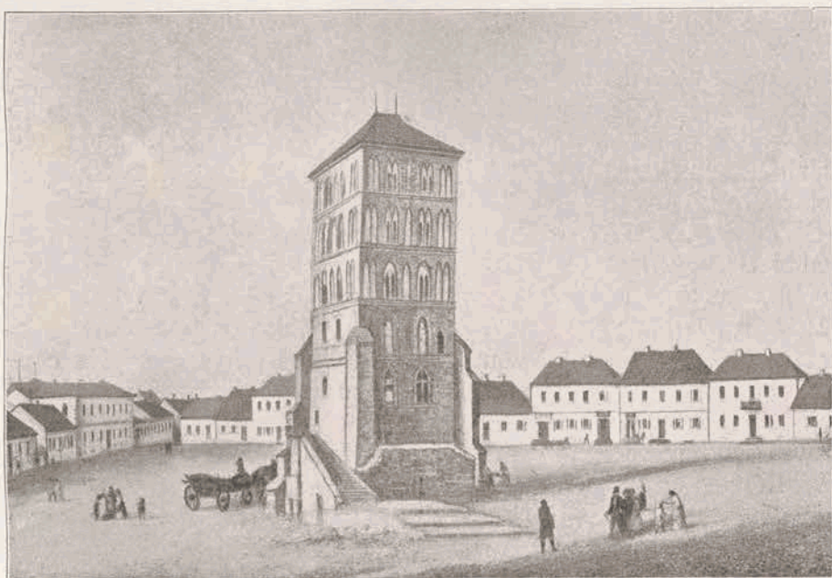
WIEŻA NIEISTNIEJĄCEGO JUŻ RATUSZA W INOWROCŁAWIU, GDZIE JADWIGA PRZYJMOWAŁA WM. KONRADA V. JUNGINGEN W R. 1397.
