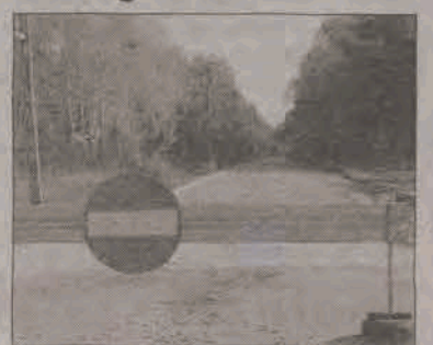
Obecnie trwają prace przy budowie nawierzchni części ul. Wypiańskiego.
