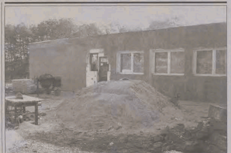
Ekipa zaczęła od termomodernizacji budynku.
